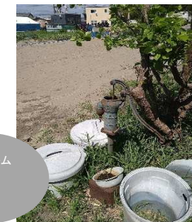
本体は錆び、消耗品も劣化していました
