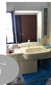
全体的に劣化が進んでいました
